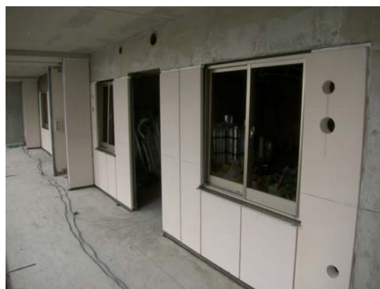
ALC化された非構造壁
