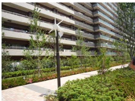
風力発電設備
