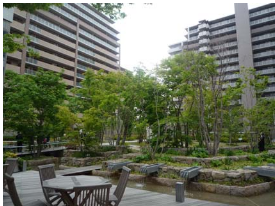
ビオトープを盛り込んだ中庭空間
