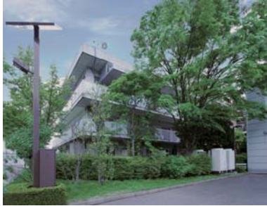
技術研究所・住宅性能試験棟
