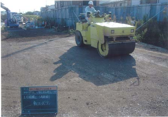
路盤に再生砕石を使用
