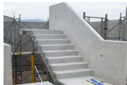
● フルPC階段の据付け
