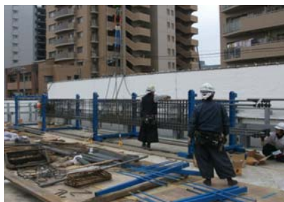
● 長尺桁梁鉄筋の先組み
