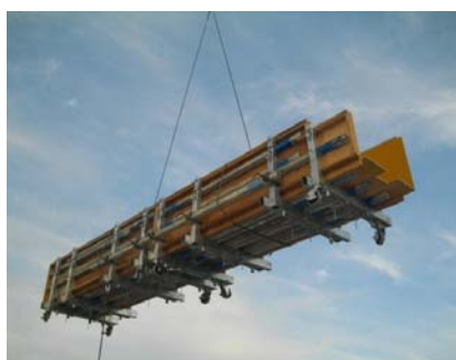
● システム梁型枠の揚重
