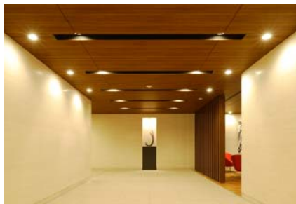
エントランスLED照明
