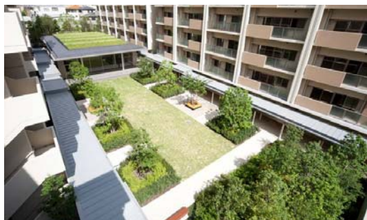
共用棟の屋上緑化
