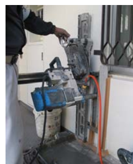
後施工部分スリットの施工
