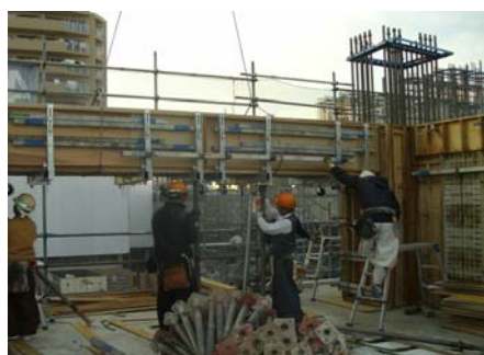
● システム梁型枠の建込み
