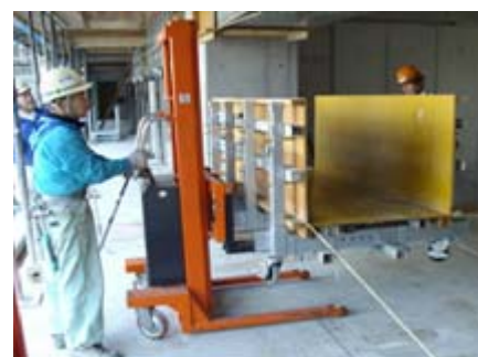
● システム梁型枠の解体
