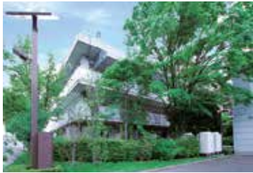
技術研究所・住宅性能試験棟
