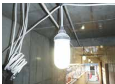
仮設通路照明にLED球を採用
