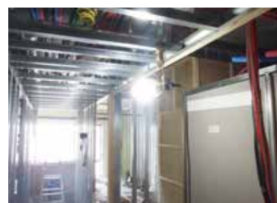
内装作業照明に蛍光灯を採用
