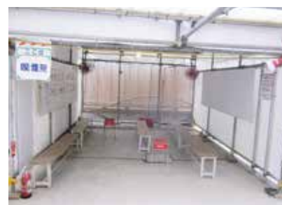
休憩所の通風改善と日よけの設置
