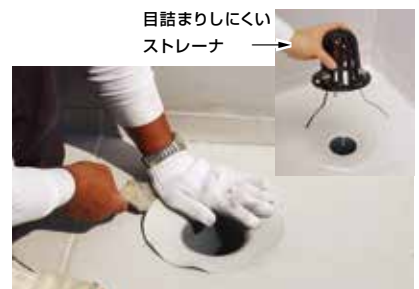
縮径しないドレン施工状況
