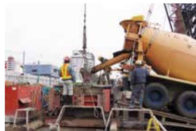
杭コンクリート打設状況
