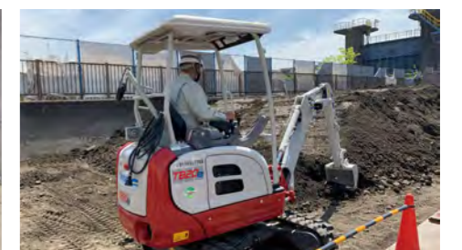
電動バックホーの採用 (試験採用)
