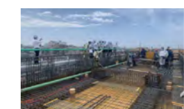
H-BAコンクリート打設の様子
