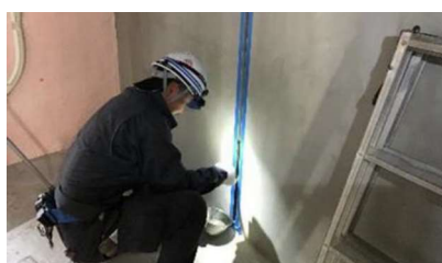
写真5 目地充填状況
