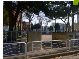
【改修前の亀戸七丁目南公園（西側入口）】
