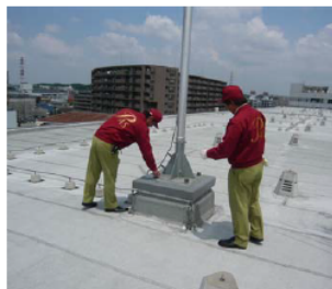
【定期点検の様子】
