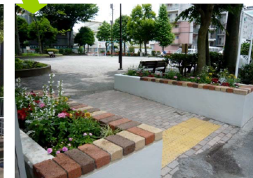
【改修後（西側入口）】
