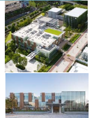
【「長谷工テクニカルセンター」外観】
