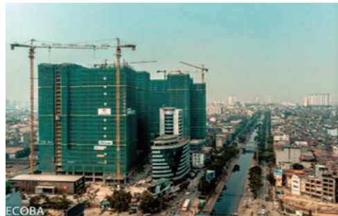
【施工実績一例】201 Minh Khai Plaza
