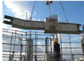
PCa梁の施工状況
