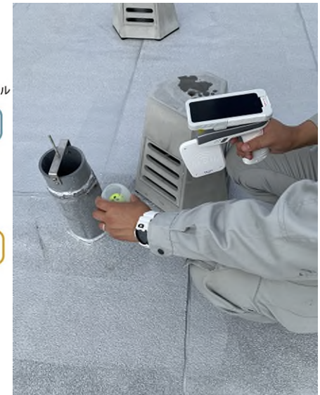
試験ボール投入の様子
