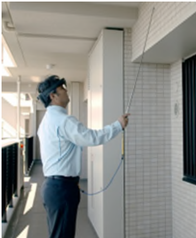
HoloLens2を付けた打診検査の様子
