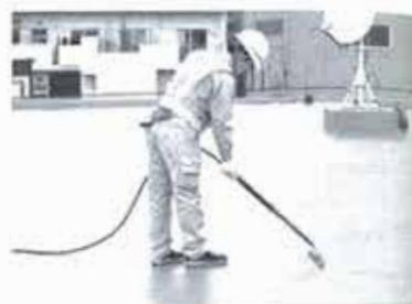
写真1 専用機器による異常箇所の発見
