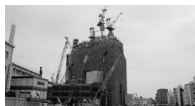
建設の進む「東京スカイツリー」
