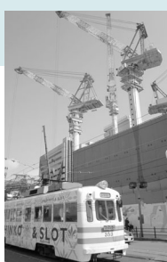
「阿部野橋ターミナルビルタワー館(仮称)」の建設現場
