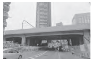
駅の東西を結ぶ道路も建設中
