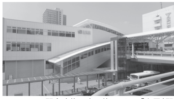
駅舎改修工事が終わったJR「上尾」駅
