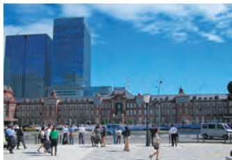
保存・修復工事が完了した東京駅丸の内駅舎
