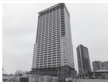
2013年1月に竣工した「クロスエアタワー」。「O-Path(オーパス)目黒大橋」全景住宅だけでなく、図書館などの公共施設もある
