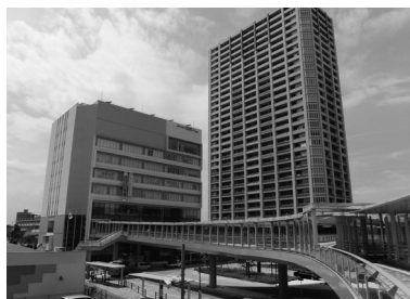
2013年1月に完成した「サウスピア」と「プラウドタワー武蔵浦和マックス」
