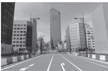
3月29日に開通した環状2号線「新虎通り」
