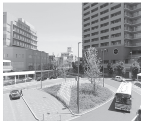
整備された駅前広場と駅前ロータリー
